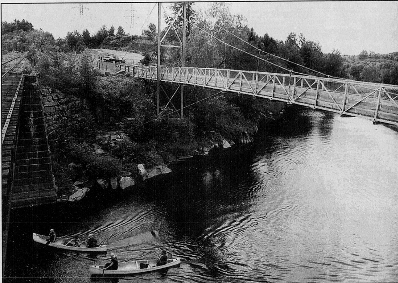
Tout va bientôt s'arranger pour le réseau cyclable traversant l'arrondissement de Bromptonville. Un tracé alternatif viendra combler la brèche actuelle. Résultat, le pont Bernier, une structure construite avec le support des Forces armées canadiennes, qui demeurait fermée en raison de cette brèche, pourra être emprunté par les cyclistes.
