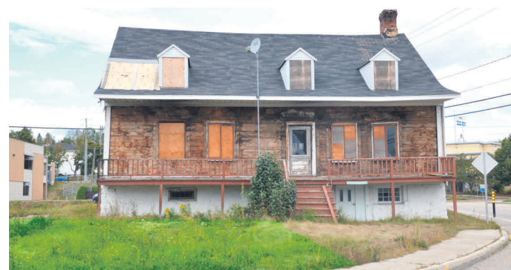
Voici l'allure actuelle de la Maison Lapointe. À la une, une modélisation de l'éventuelle restauration de la façade.
