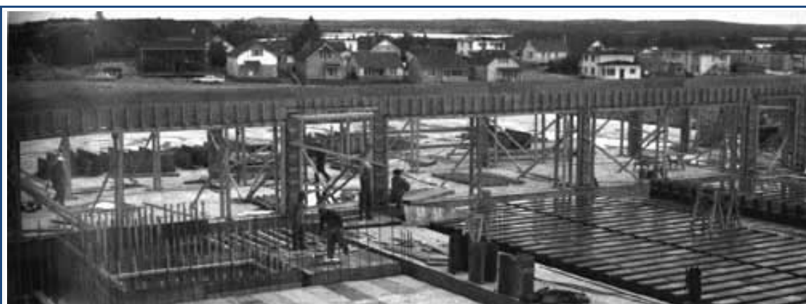
Construction de l'école secondaire d'Iberville en 1970
