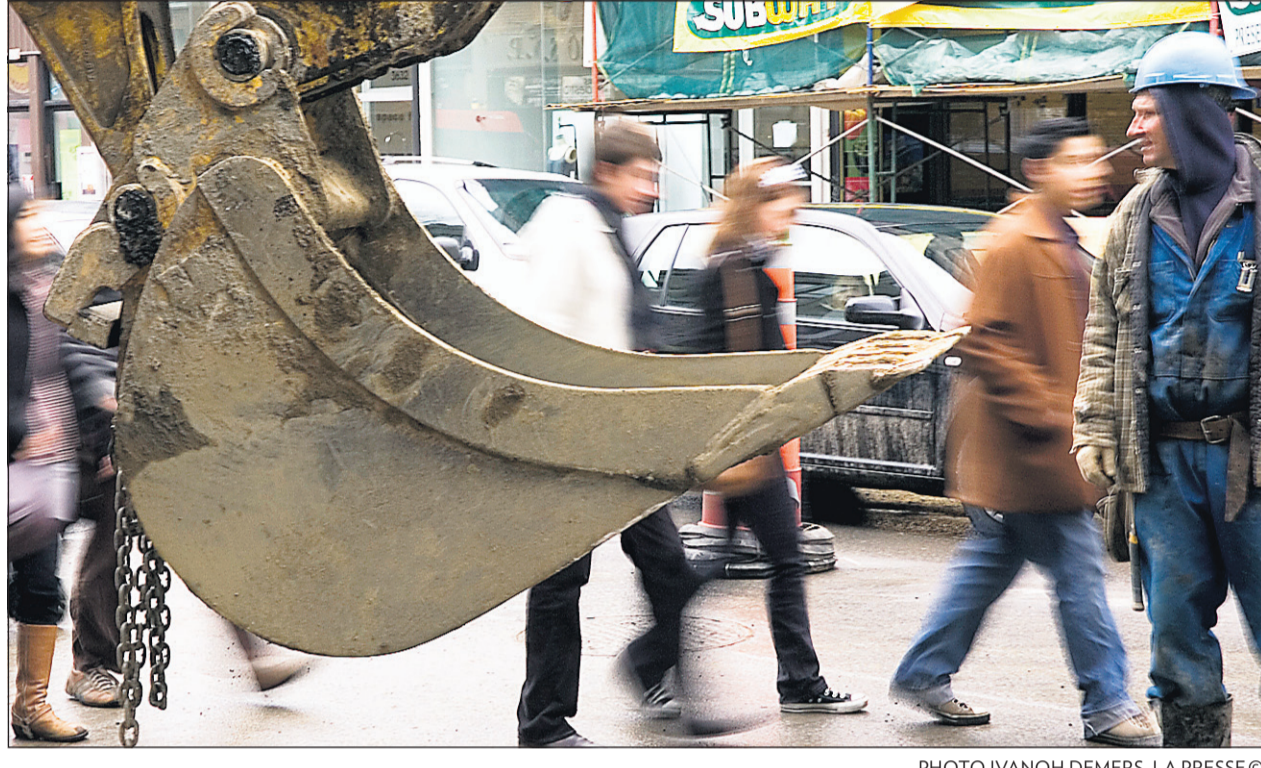
Les effets négatifs de la construction nuisent aux commerces du boulevard Saint-Laurent. PHOTO IVANOH DEMERS, LA PRESSE
