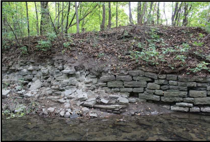
Photo 7 : Jonction entre une partie plus ancienne de l'aile nord-est du barrage Brown et une partie plus récente qui en forme le plus long segment (M. Goyette, Ville de Québec, A-15-06-56).
