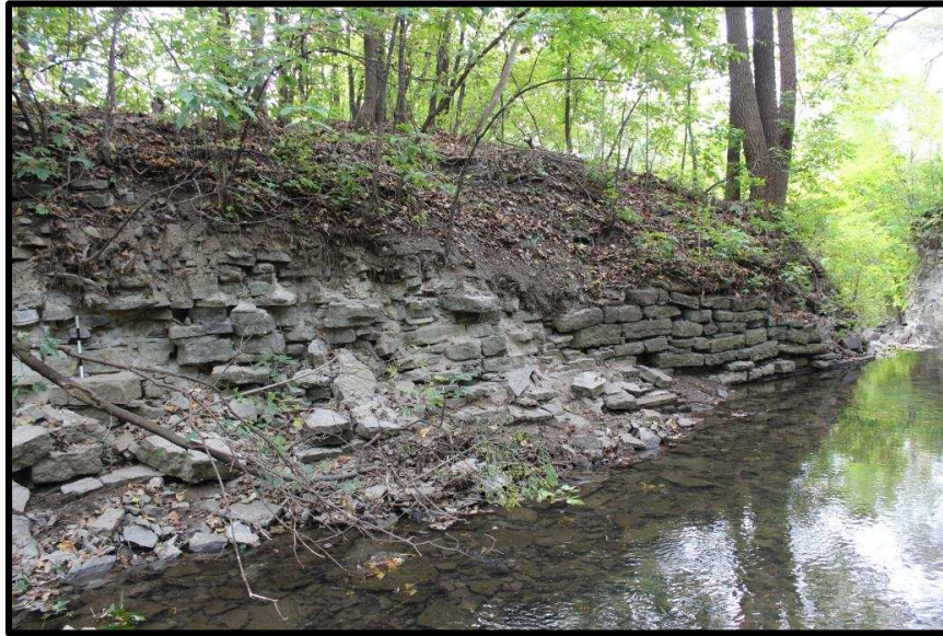
Photo 2 : CfEt-26, vestiges du barrage Brown : aile nord-est, vers le sud-est (M. Goyette, Ville de Québec, A-15-12-63).
