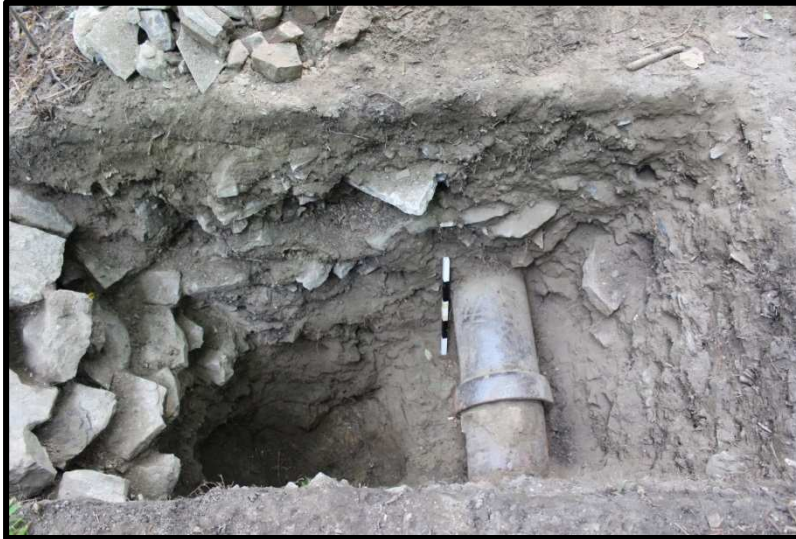
Photo 17 : Conduite de grès installée derrière le muret de soutènement lors de l'aménagement de la rue Chabanel peu avant 1867, dans le sondage CfEt-26-1M (M. Goyette, Ville de Québec, A-15-06-08).
