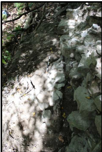
Photo 11 : Vestige plus ancien au pied de l'aile nord-est du barrage Brown, vers le nord (M. Goyette, Ville de Québec, A-15-12-06).
