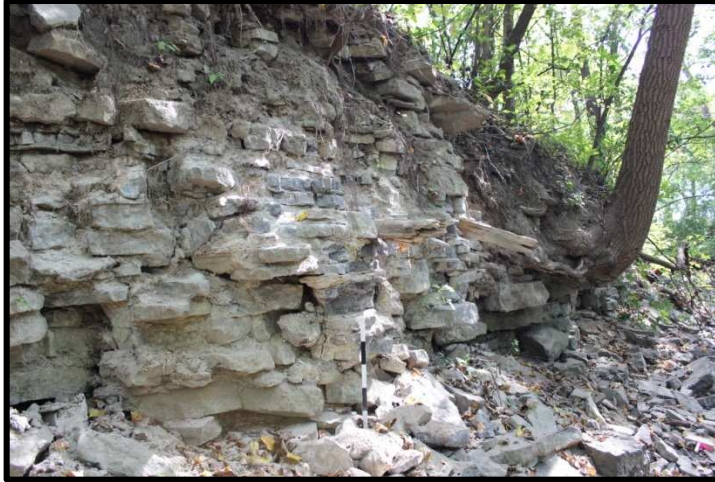
Photo 13 : Paire de pièces de bois fichées dans la maçonnerie de l'aile nord-est du barrage Brown et pouvant être associée à un deuxième ponceau permettant de traverser la rivière (M. Goyette, Ville de Québec, A-15-12-20).
