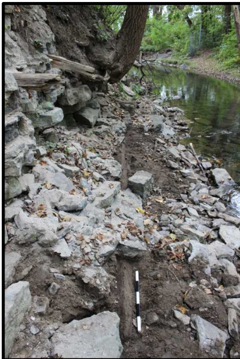
Photo 9 : Parement ouest résiduel de l'aile nord-est du barrage Brown, vers le sud (M. Goyette, Ville de Québec, A-15-12-77).
