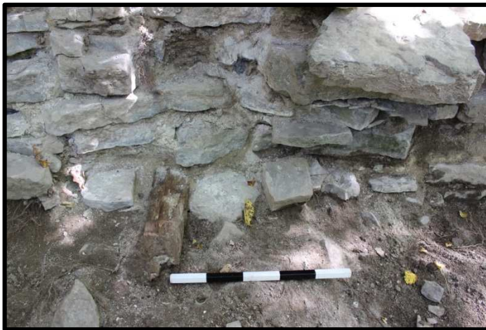
Photo 12 : Pièce de bois fichée dans la maçonnerie à l'extrémité nord de l'aile nord-est du Barrage Brown et pouvant être associée à un premier ponceau (M. Goyette, Ville de Québec, A-15-12-04).
