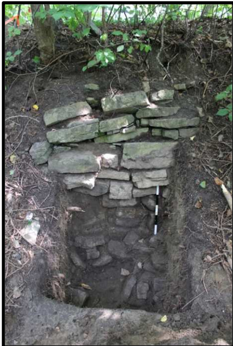
Photo 16 : Vue du parement est du muret de soutènement érigé peu avant 1867, dans le sondage CfEt-26-1P (M. Goyette, Ville de Québec, A-15-05-50).
