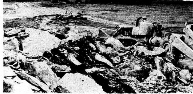
La voie d'accès à l'autoroute à Cowansville
