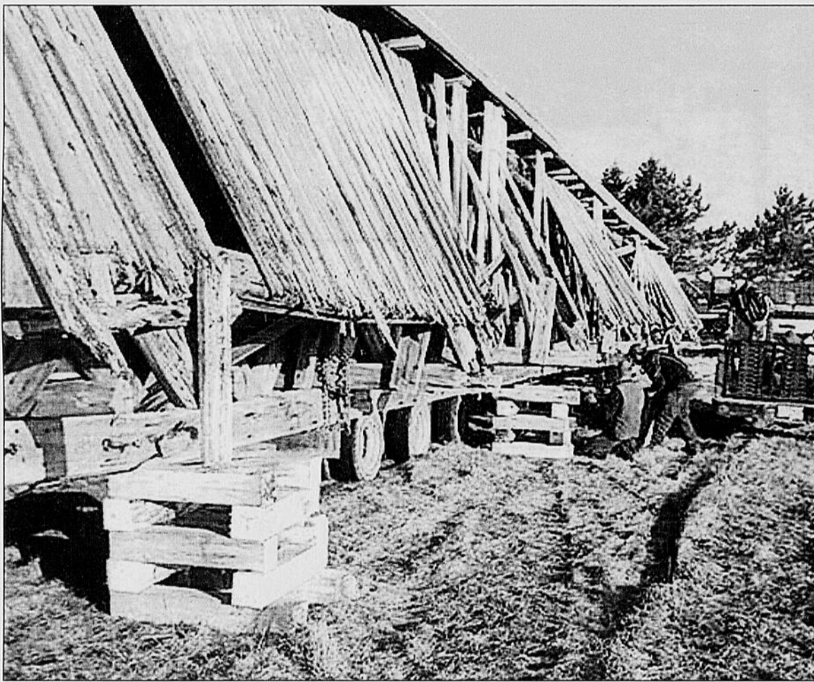
Le pont couvert repose maintenant sur le terrain d'une résidence située sur la route 169 où les réparations seront effectuées.
