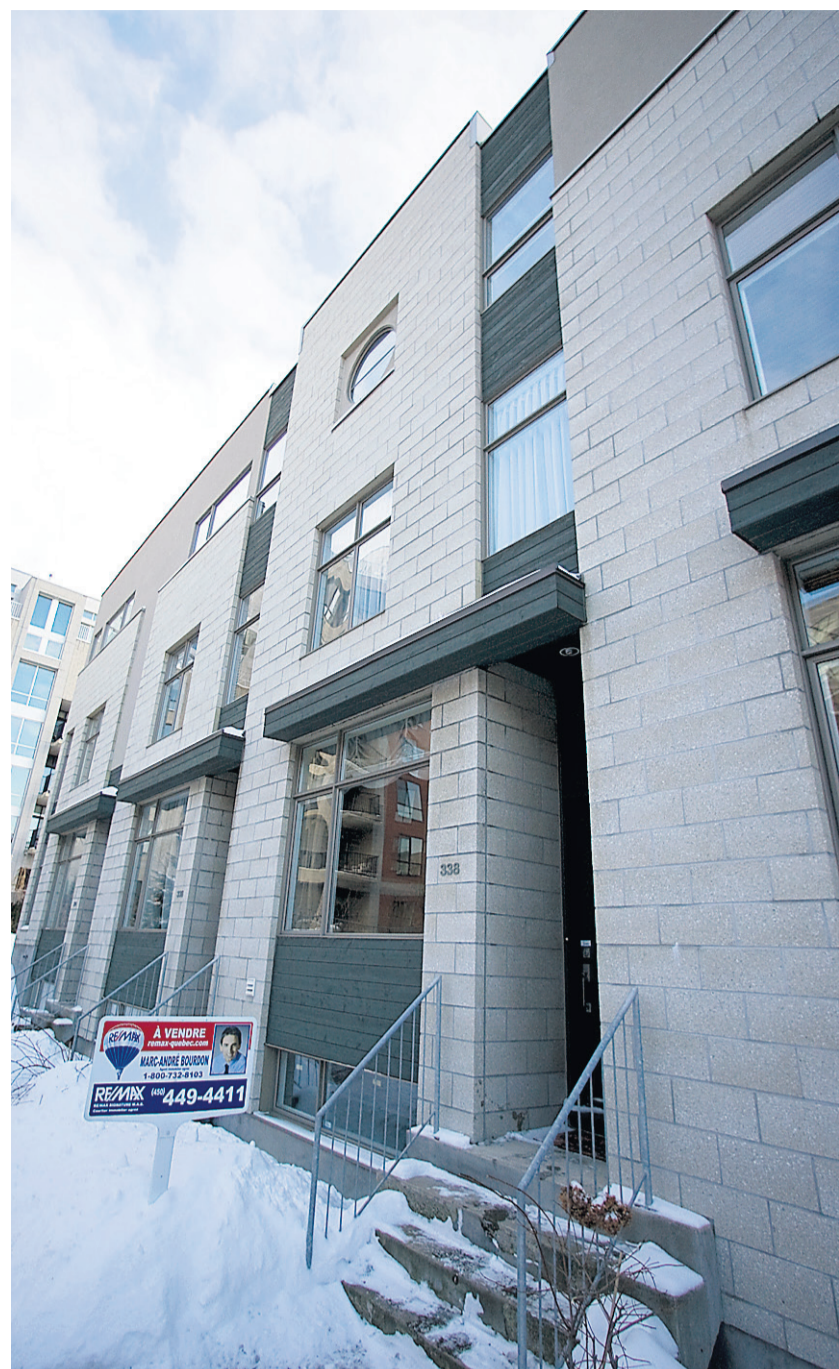
Cet ensemble de huit maisons en rangée donne sur une rue piétonne. Pas de voiture dans les parages! Le revêtement de la façade en tons de gris et de noir permet de marier le style des maisons aux immeubles du Vieux-Montréal.
