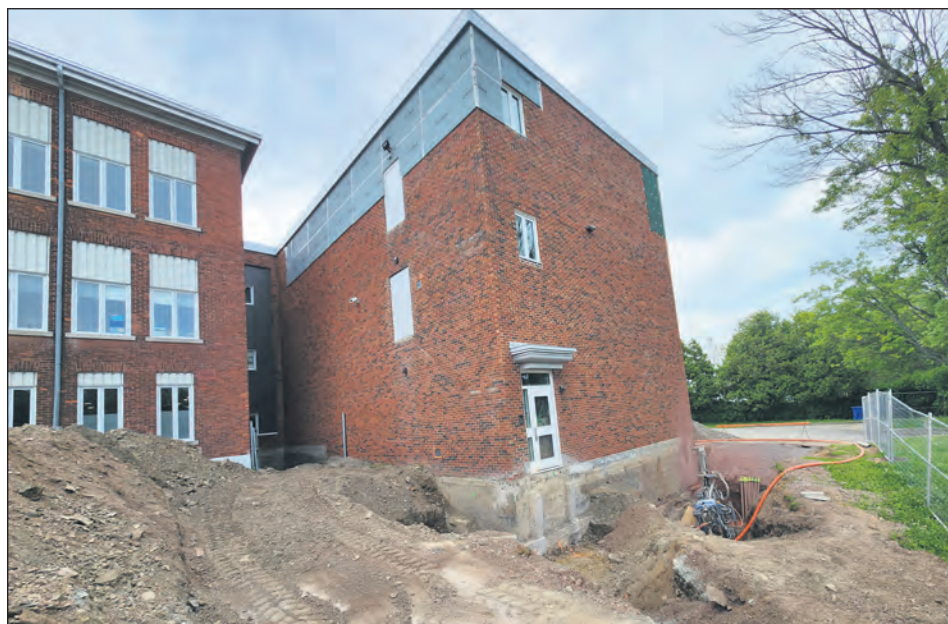
Chantier à l'École La Croisée I de Rivière-du-Loup.
