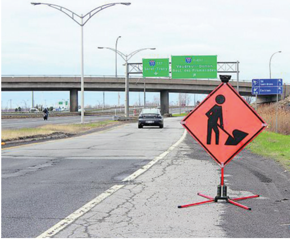
Les travaux qui se réaliseront en deux phases se poursuivront jusqu'au mois d'octobre. (Photo : archives)
