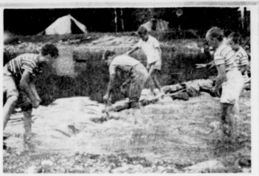
UN BARRAGE — Pour leur permettre de se baigner, les 4H travaillent à l'aménagement d'un barrage sur la rivière longeant leur camp.
