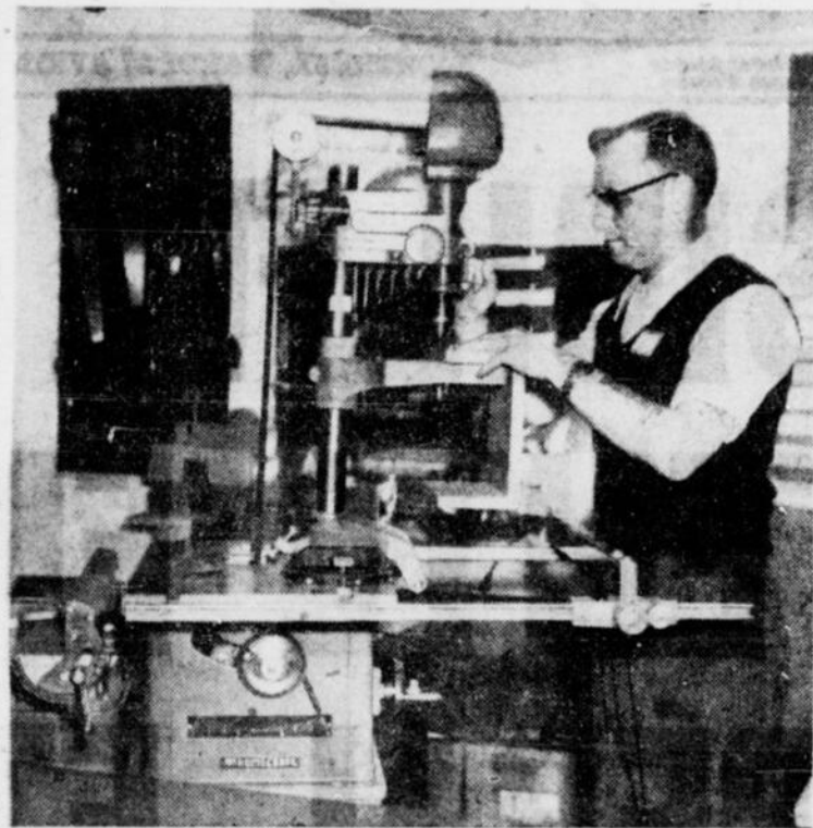
(Photo J.-P. LeBlond—La Patrie) NOUVELLE MACHINE DE MENUISERIE — A l'exposition de la maison modélée au Palais du Commerce qui se tient jusqu'au 2 mai, M. Frank Bélanger perce une boîte à fleurs avec cette machine très perfectionnée. La machine comporte une scie ronde, un convoyeur, une foreuse, une sableuse à disque.
