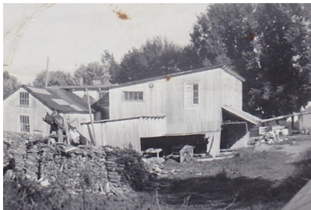
Arrière du moulin à scie et tas de croutes. Au-dessus du moulin à scie on trouvait la boutique à bois et à gauche l'entrepôt pour les poches prêtes à livrer. Le moulin à farine se trouvait à l'avant de cet entrepôt.
