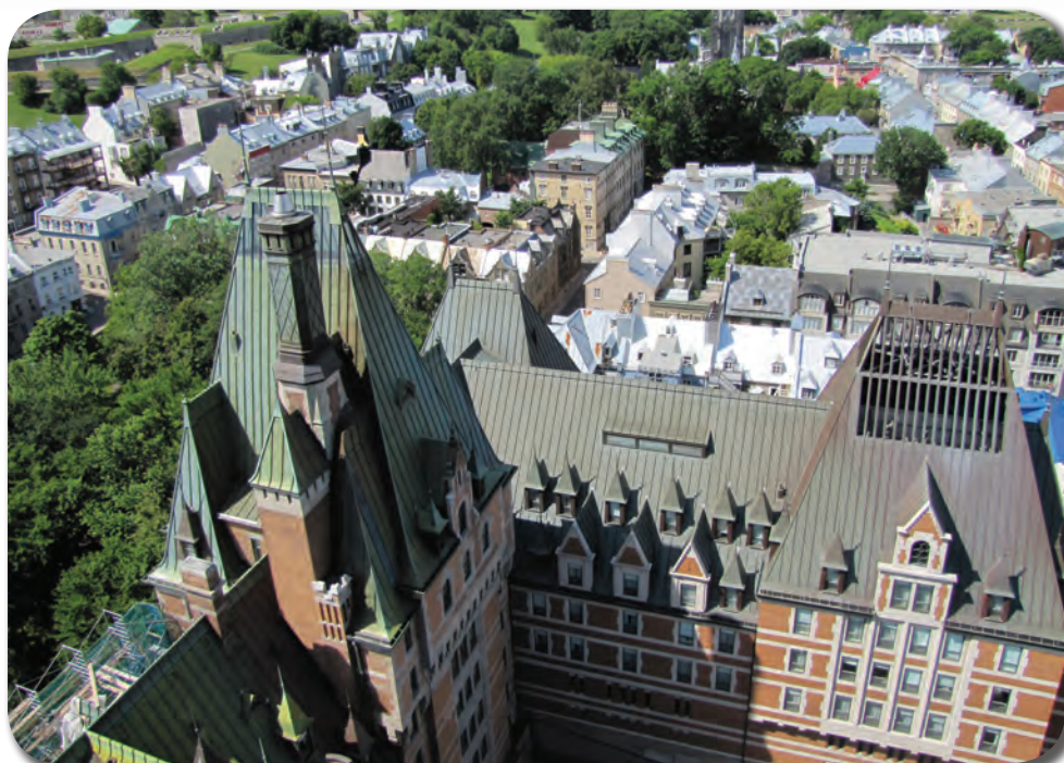
Vue à partir du toit de la tour centrale
