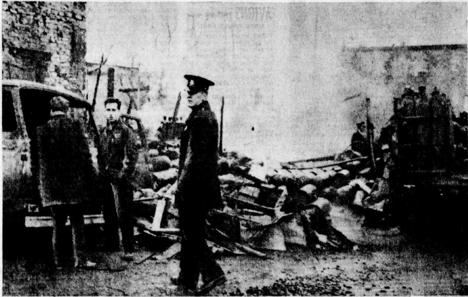
EXPLOSION — Un policier surveille les ruines des établissements de la compagnie Canadian Oxygen, à Ottawa, à la suite de l'explosion de réservoirs d'oxygène liquide qui a causé la mort
