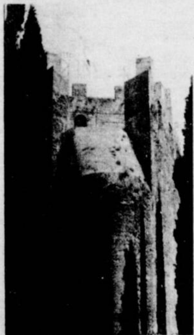
L'arrière du château de Roccasinibalda.
