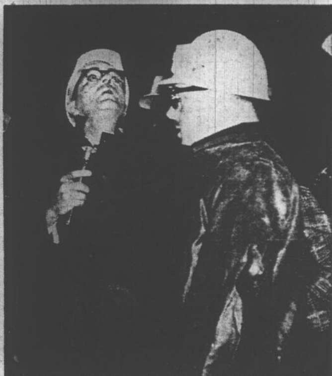
SPECTATEURS INTERESSES — Plusieurs représentants de la cité ont visité les travaux du métro, à l'intersection Jarry-Berri, hier matin. Sur la photo du haut, le maire Jean Drapeau ouvre la marche, tandis que, sur la photo du bas, M. Drapeau et M. Lucien Saulnier étudient attentivement la marche des travaux. (Photos André Hébert)
