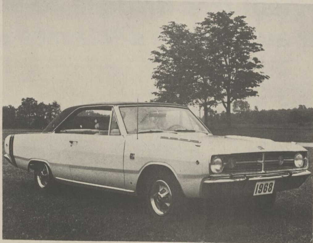
DODGE Dart GT 1968 — Cette voiture trouve son énergie dans le V-8 340 pouces cubes de conception nouvelle avec un carburateur à quatre corps et un échappement jumelé. Parmi les caractéristiques, il y a la suspension à service dur du genre rallye. On obtient aussi sur ce modèle un moteur de 383 pouces cubes cylindrée avec un carburateur à quatre corps et soit la transmission automatique ou la manuelle à quatre vitesses.
