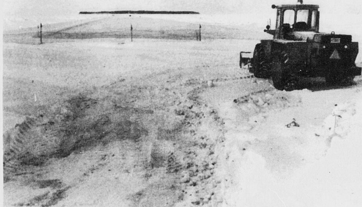
2,5 KILOMÈTRES — Une fois terminé, l'impressionnant pont de glace sera long de 2,5 kilomètres sur une quarantaine de mètres de large.
