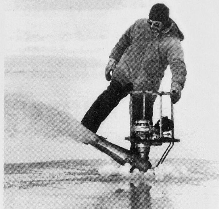
DE L'EAU — Cet employé de l'entreprise Claveau et Fils surveille le débit de cette pompe qui crache son eau sur le futur pont de glace.
