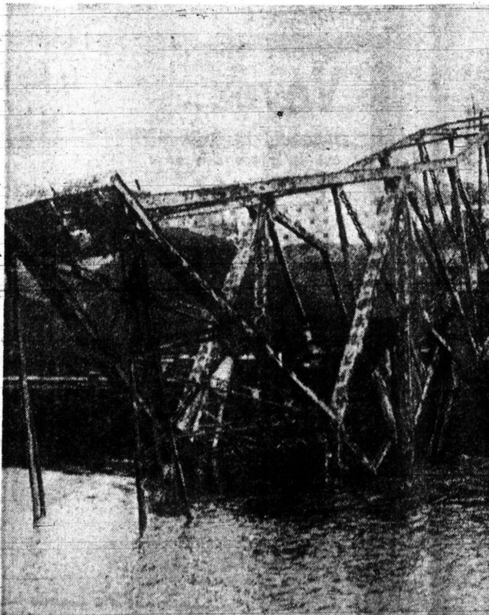
ACCIDENT PEU BANAL — Cet amas de ferraille est ce qui reste de la "Enterprise" après son effondrement. Elle servait à décharger les bateaux dans le port de Milwaukee. On se préparait à la désaffecter, lorsqu'elle s'est effondrée. (Fac-similé United Press — "Montréal-Matin")
