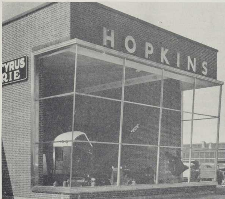
Salle d'exposition et de vente, de la firme F. H. Hopkins Ltd., Boulevard Décarie, Montréal. (Architectes : Barott, Marshall, Montgomery & Merrett. — Entrepreneur : J. S. Hewson Limited. — Vitre : Consolidated Glass Ltd.)
