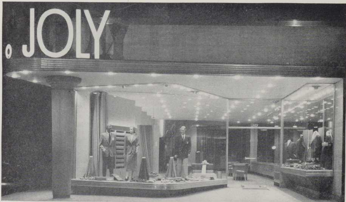
Magasin de vêtements pour hommes, Joly, rue Sainte-Catherine est, Montréal. (Architecte : Lucien Lemieux, — Entrepreneur : J. P. Cartier. — Vitrerie : Hobbs Glass Ltd.)
