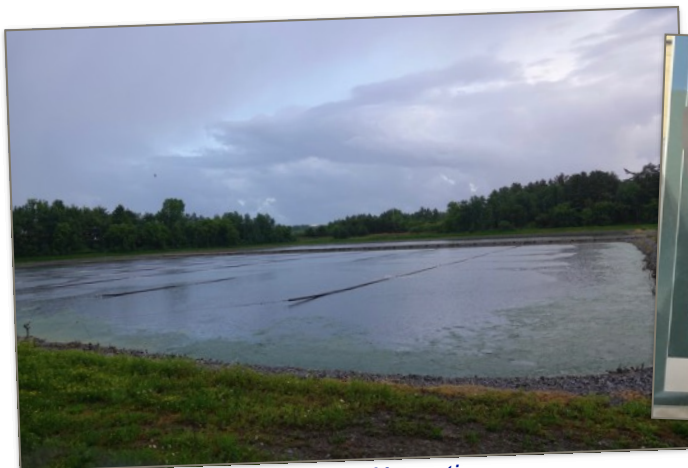
Les bassins d'épuration
