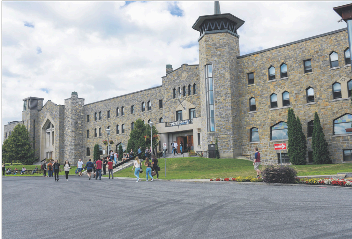
Le Cégep prévoit plusieurs travaux de maçonnerie, de toiture, de drainage, de mise aux normes pour une somme de 2,9 M$.
