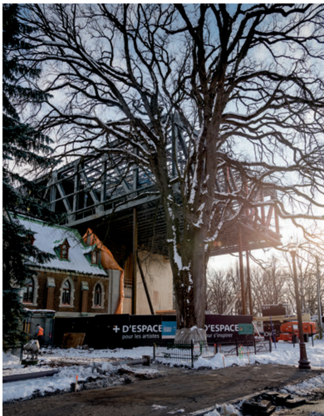
Le chantier du nouveau pavillon en novembre 2014.
