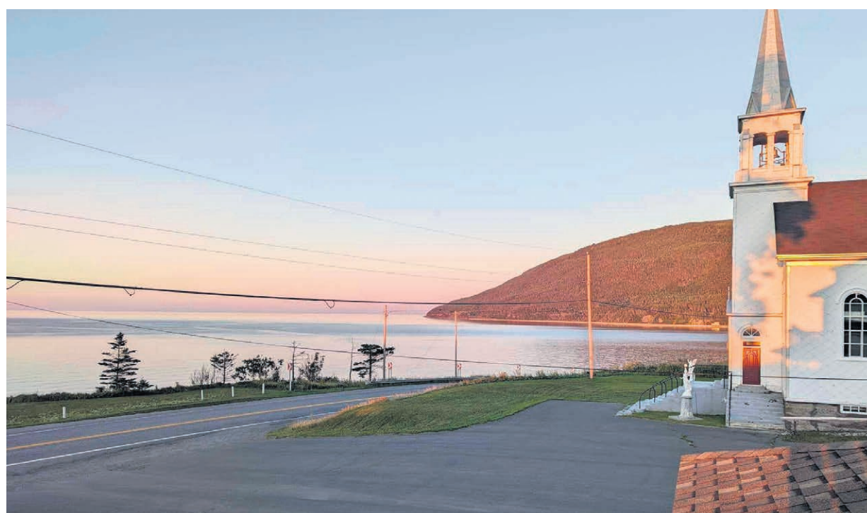
L'église de Rivière-à-Claude a été construite en 1926-1927.
