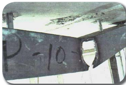
Vue de l'ouverture qui a été faite par le procédé d'oxycoupage.
