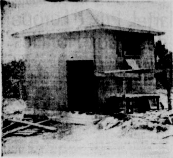
DANS LE BUT D'AMELIORER le service d'aqueduc, la ville de Shawinigan a construit une station de pompage. Celle que l'on voit sur la photo a été construite à la coopérative St-Georges et une autre le sera dans Shawinigan-Est. Cette dernière exemplera la ville d'acheter de l'eau de Grand'Mère.
