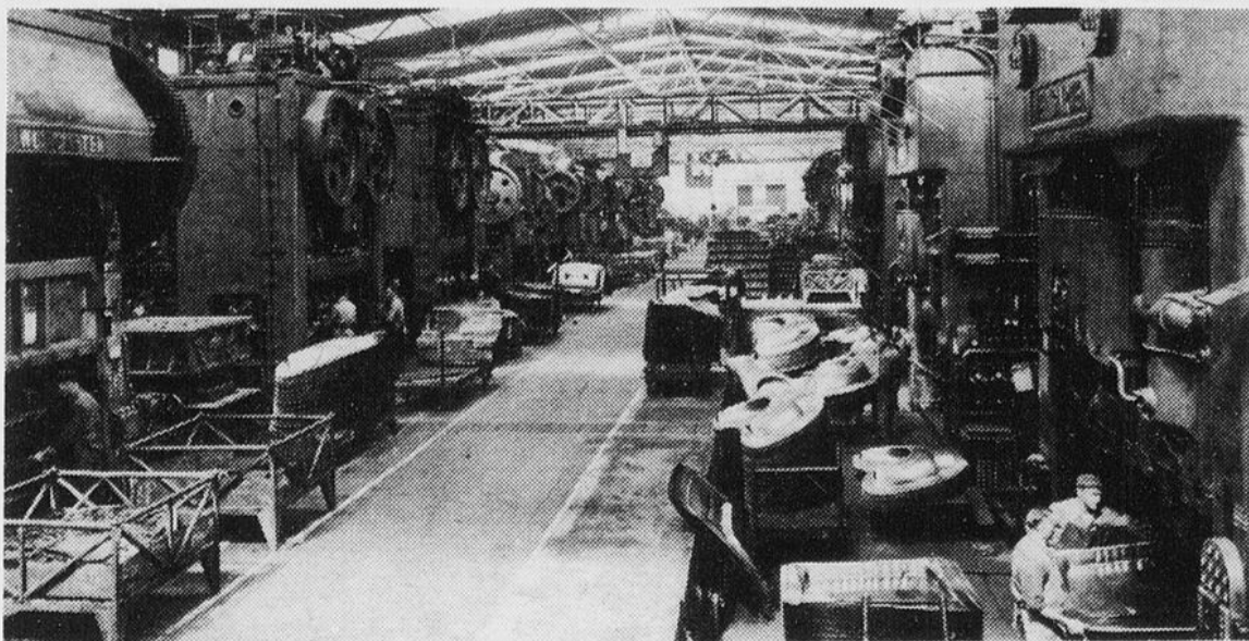
Rue des presses à l'usine Sindelfingen de la Daimler-Benz A.-G.
