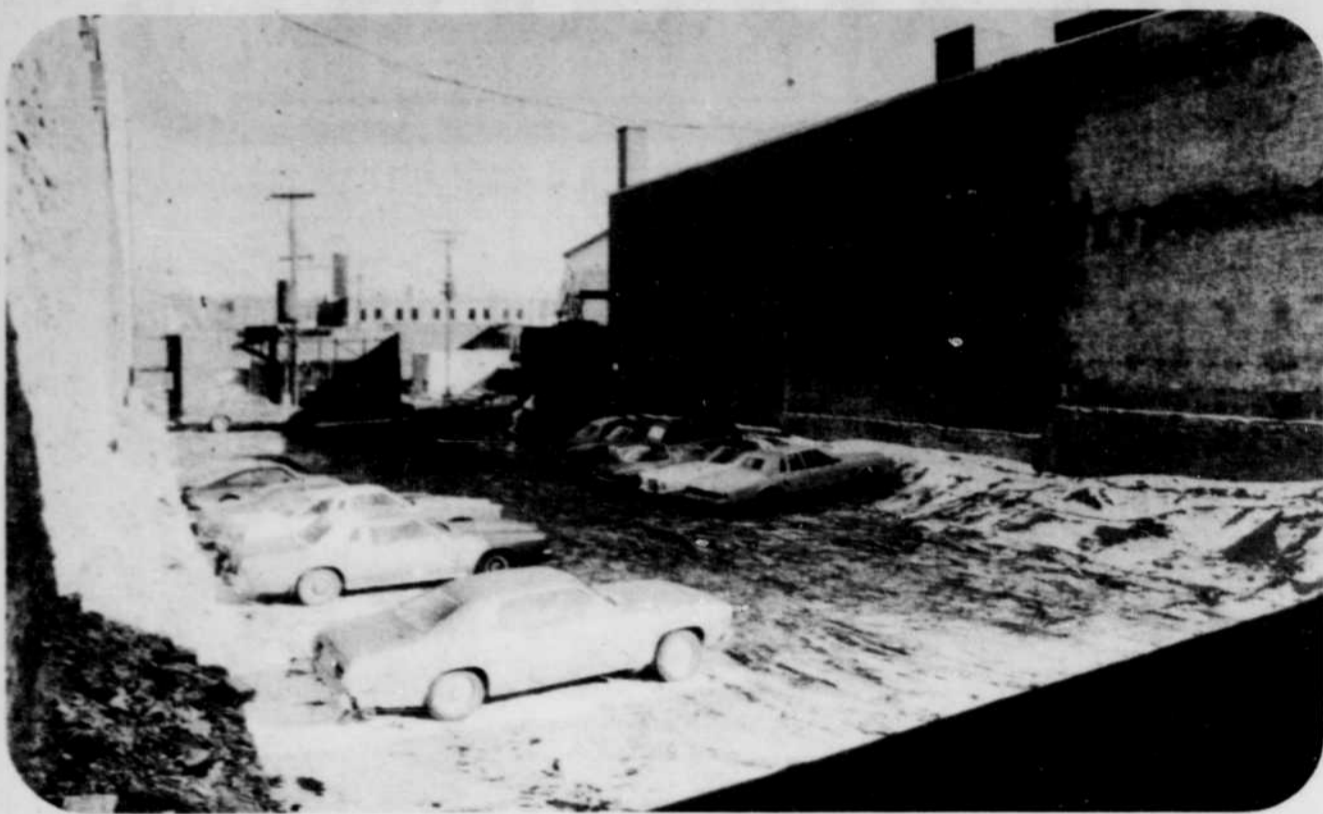
Un nouvel édifice sera construit sur le terrain laissé vacant par l'incendie qui a ravagé le magasin Woolworth, le 1er avril 1979.
