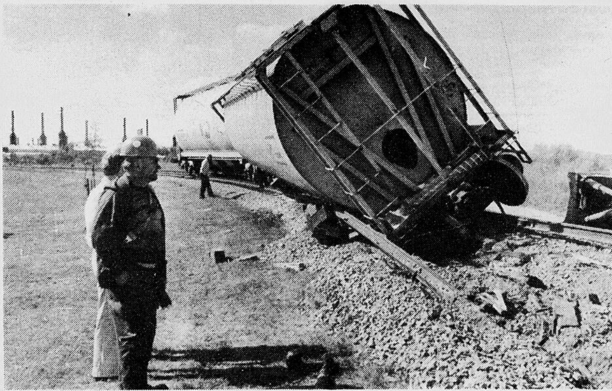
DERAILEMENT — Des employés de Roberval-Saguenay constatent "de visu" l'étendue
