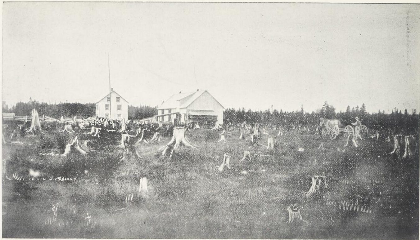
SAINT-CAMILLE.—Nouvelle mission, à 5 lieues de St-Magloire Premiers défrichements.
