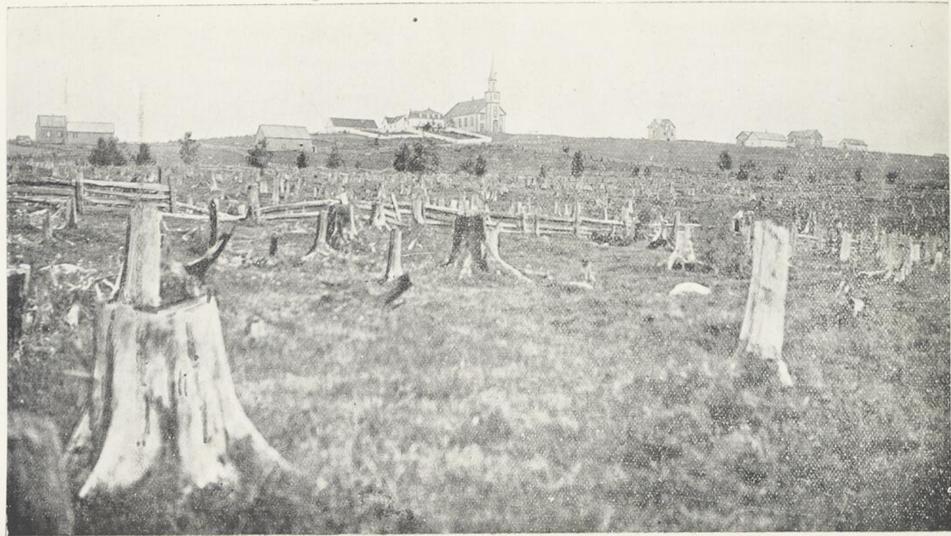
SAINTE-ROSE.—Eglise et environs. Travaux de défrichage et habitations de colons.
