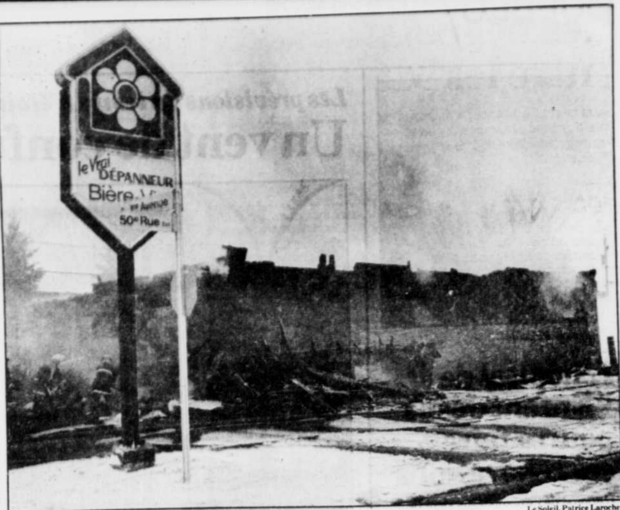
À l'arrivée des premiers policiers-pompiers de Charlesbourg, le toit du dépanneur flambait.
