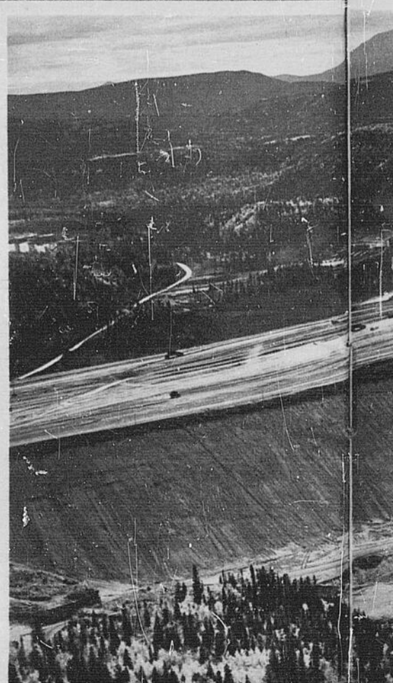
COLOMBIE: le barrage de Portage Mountain, sur la rivière-à-la-Paix.
