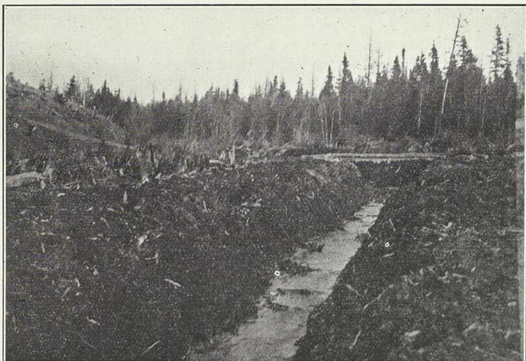
Cours d'eau municipal bien fait au moyen de la pelle à cheval. A remarquer l'épandage régulier des levées et l'inclinaison des talus
