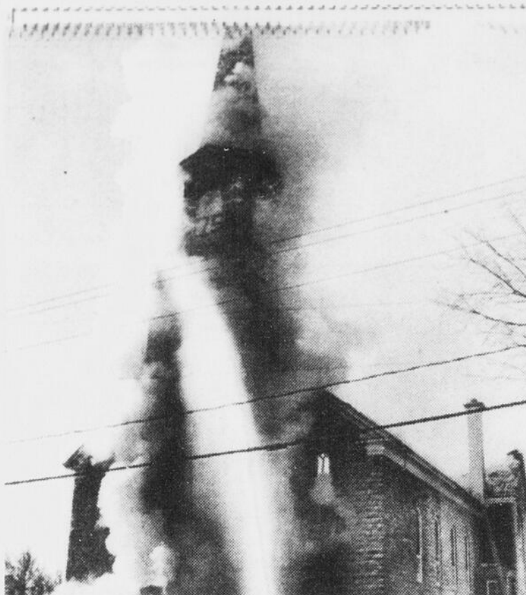
CLOCHER — Le clocher, tout comme le reste de l'édifice, n'a pas résisté aux flammes, lors de l'incendie, hier, de l'église de Saint-Octave-de-Dosquet, dans le comté de Lotbinière, au sud-ouest de Québec. (Laserphoto PC)
