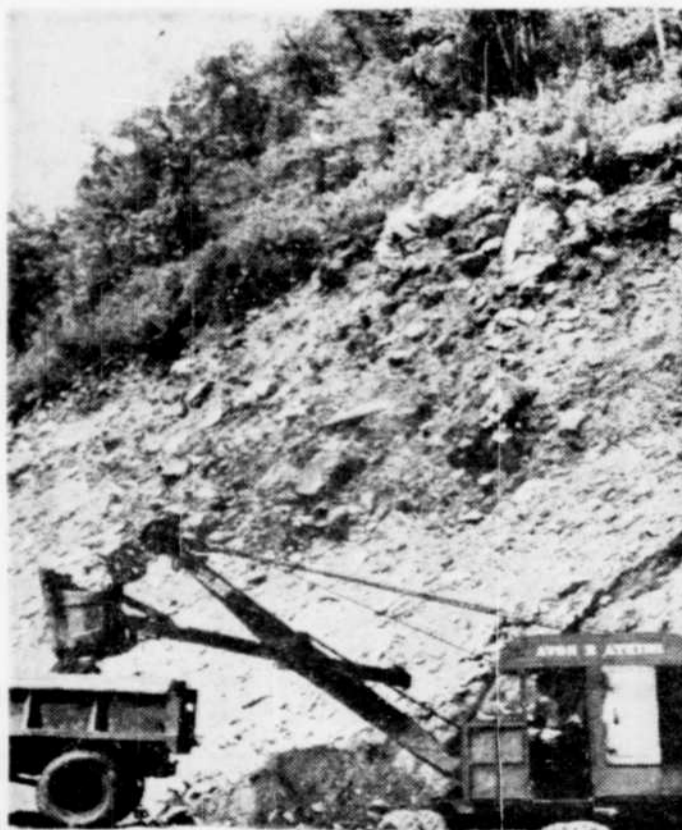
Le déblaiement au pied de la falaise
