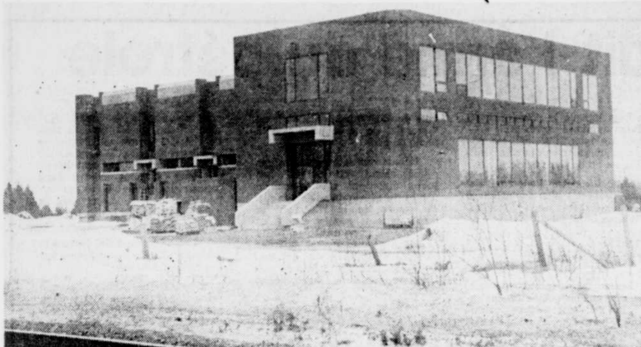
L'usine de filtration de Rivière-du-Loup.
