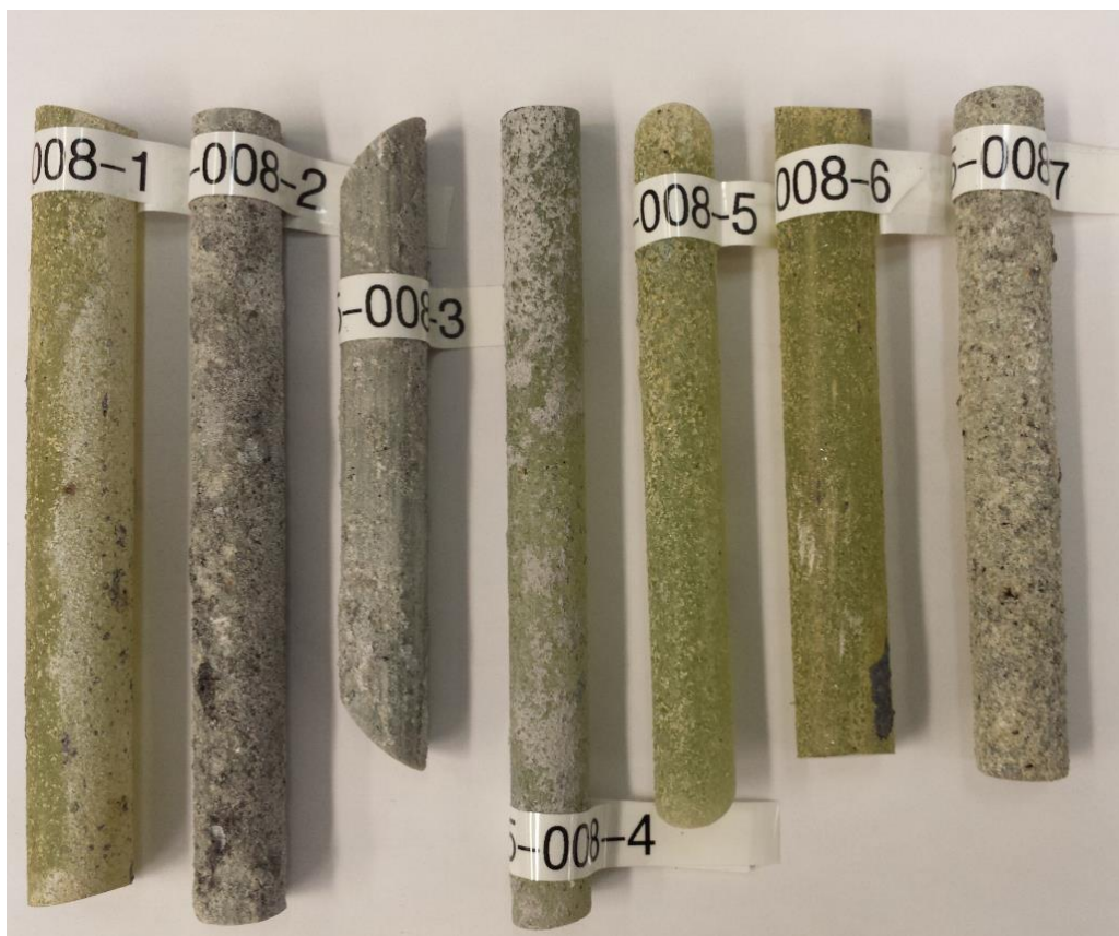
Figure 3 – Échantillons de barres d'armature en PRFV provenant des carottes de béton C1 et C3
