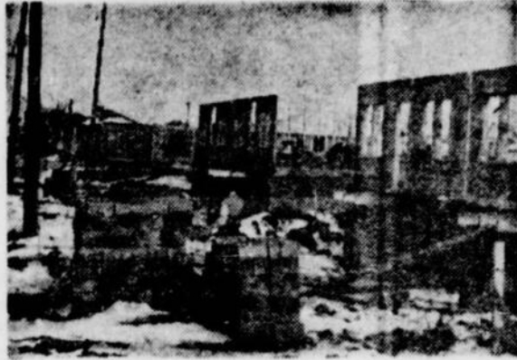
→ 18 habitations en cours sur rue Delorimier, entre Ste-Foye et Tilmont, en- core les constructeurs MODERNAIRE.
