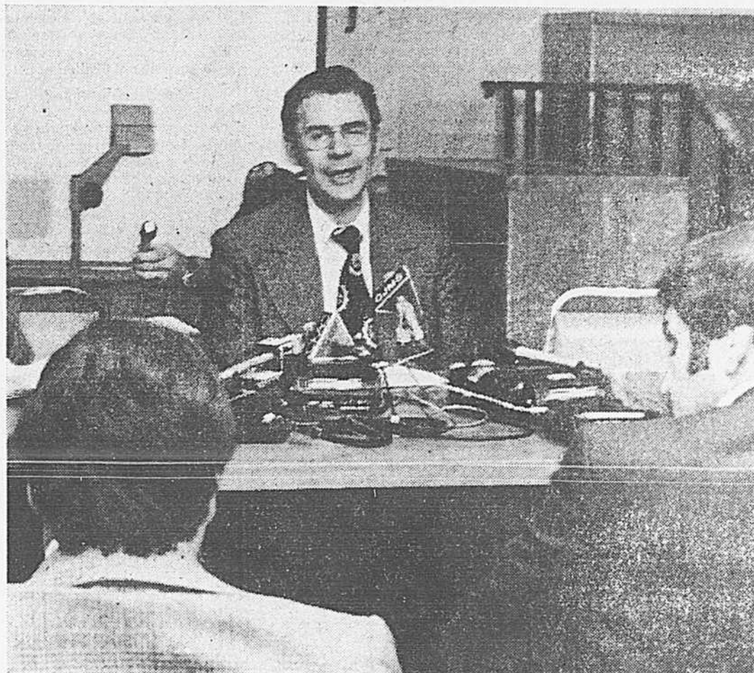
Après l'émeute et lorsque l'incendie fut éteint, le directeur de l'Institut Laval (ex-pénitencier Saint-Vincent-de-Paul) a donné une conférence de presse au cours de laquelle il a déclaré que quelque 280 détenus devraient coucher à la belle étoile puisqu'ils avaient tout détruit.
