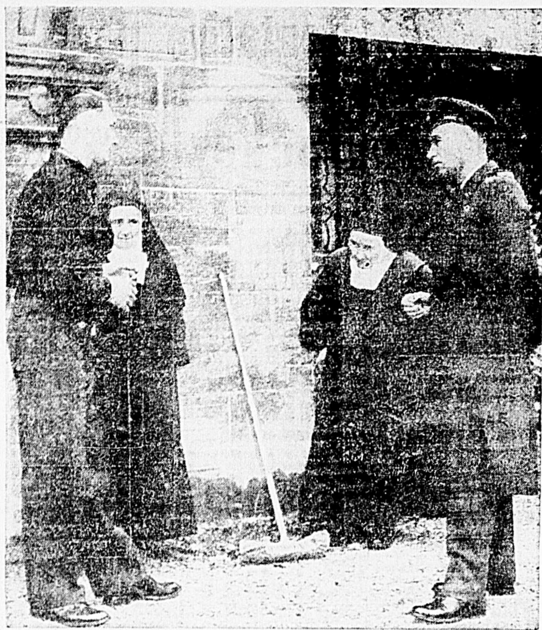
LES AVIATEURS DE L'ARC OCCUPENT LEURS LOISIRS — Les aviateurs de l'ARC, stationnés outre-mer, occupent leurs heures de loisir à convertir une vieille maison en un internat destiné à recueillir un groupe d'enfants français sans famille. Ce nouvel internat, situé à Montmédy, va bientôt ouvrir ses portes, grâce aux efforts conjugués d'un petit nombre de carmelites et des membres de la 41e escadrille (Silver Fox). A gauche de cette photo, le sous-officier breveté Danny Danforth (à gauche) et le commandant d'escadre Hugh McLaughlin discutent avec les Religieuses Carmélites des projets que les aviateurs se proposent de réaliser pendant leurs loisirs afin de compléter le programme qu'ils se sont fixé. (Photo de la Défense nationale)
