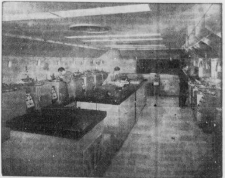
La Salle d'enregistrement ultra-moderne de l'Édifice Radio-Canada où l'on peut enregistrer automatiquement tout programme passant par la Régie centrale. Chaque table (à disque ou à bobine) possède ses propres commandes, horloge, lumière et haut-parleur. Toutes peuvent enregistrer simultanément ou individuellement.
