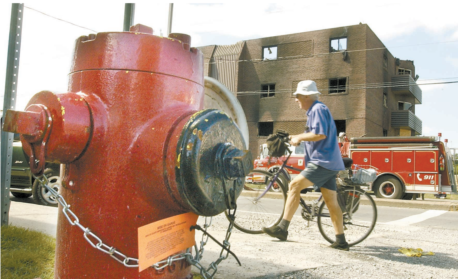
Les pompiers ont mis 13 minutes pour se rendre sur les lieux de l'incendie qui a ravagé un immeuble à logements de Greenfield Park, dimanche, et la borne d'incendie installée devant l'édifice en flammes ne fonctionnait pas (notre photo) !
