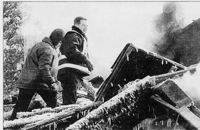
INSPECTION - Le propriétaire du garage Esso, René Claude Girard (veste de sécurité), a inspecté les décombres laissés par l'incendie qui a ravagé l'immeuble dans la soirée de mercredi.
