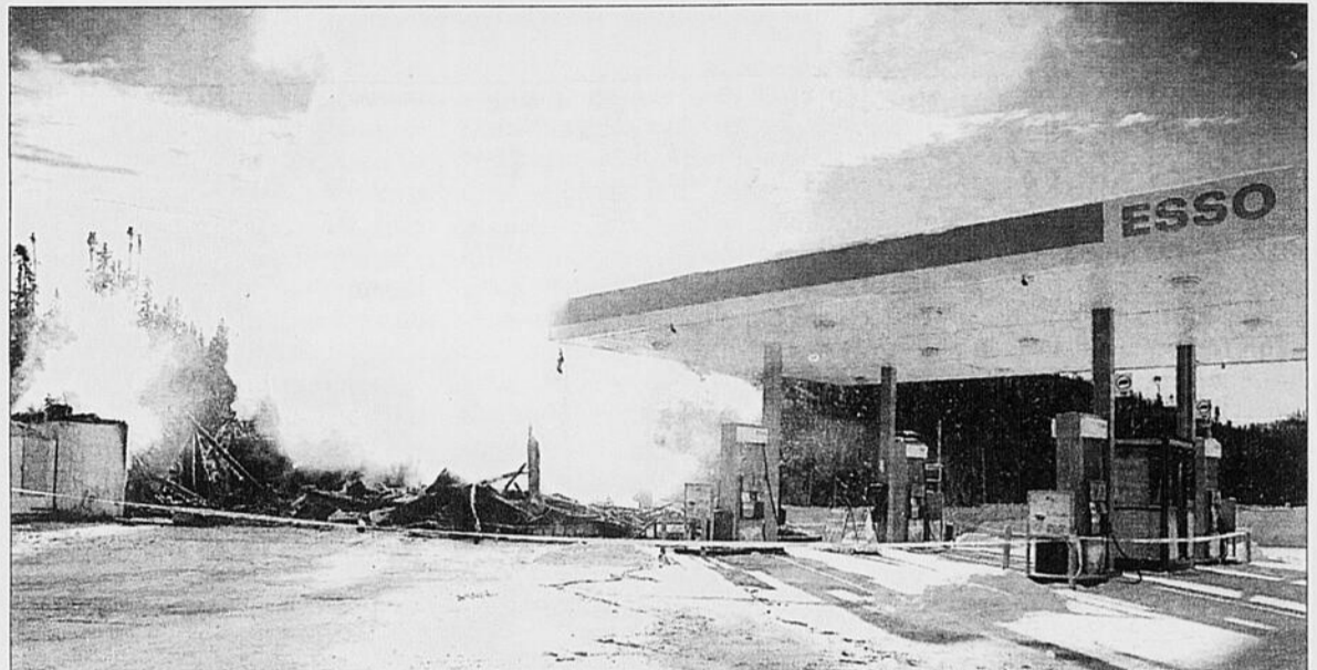
PERTE TOTALE - La bâtisse qui abritait le garage Esso dans la Réserve faunique des Laurentides a été complètement rasée par les flammes.
