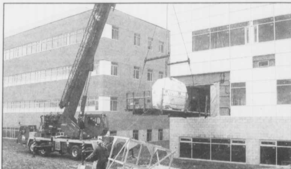
Il a fallu à une énorme grue et son grutier une précision d'horloger pour enfile le nouvel appareil d'imagerie par résonance magnétique dans un espace juste assez grand pour les besoins de la chose.
