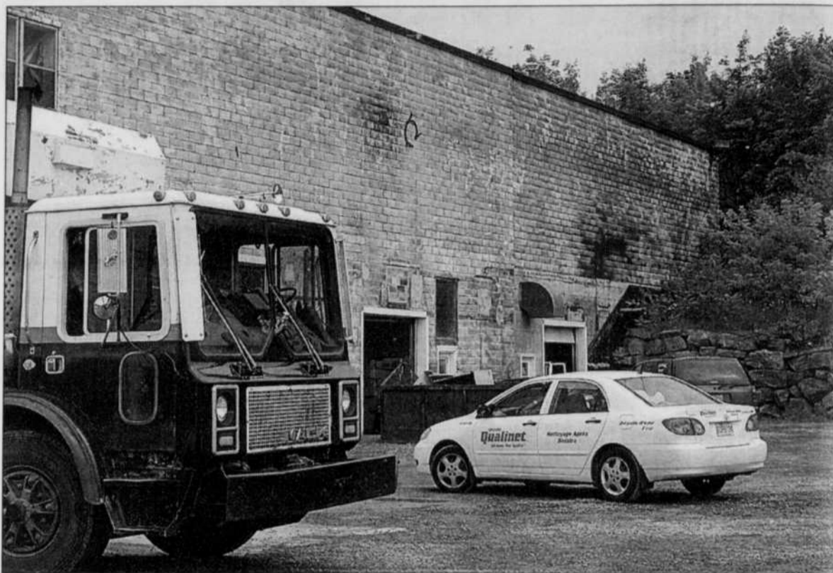
C'est dans une partie de l'ancienne usine Stanley de Roxton Pond qu'un incendie a endommagé les locaux occupés par l'entreprise AC Friction 2005, hier matin. La défectuosité d'un four fabriquant des garnitures de frein à tambour est à l'origine du feu.
