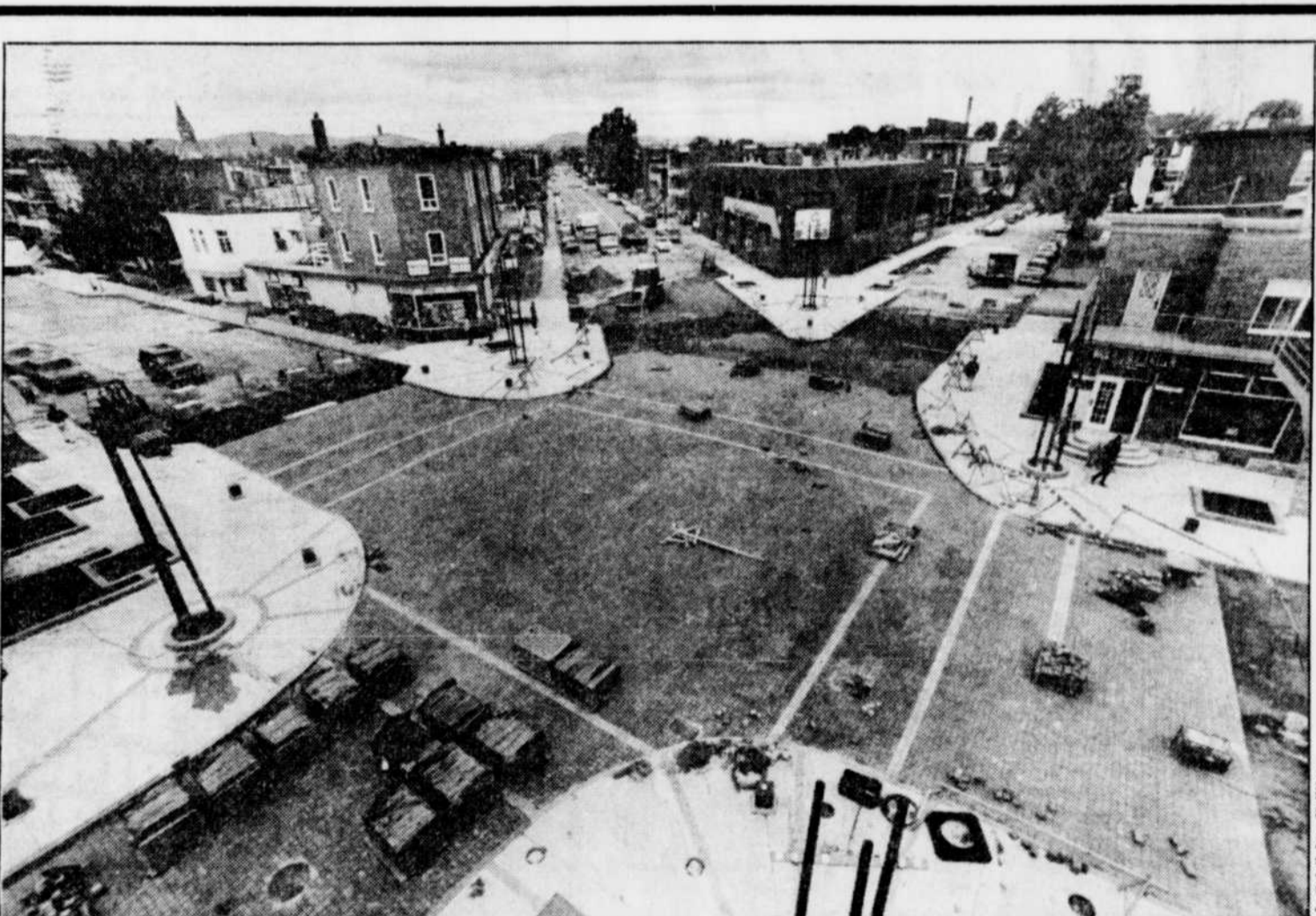
Les travaux d'aménagement de la 3e Avenue à Limoilou sont pratiquement terminés. C'est le 8 octobre que la place sera inaugurée
