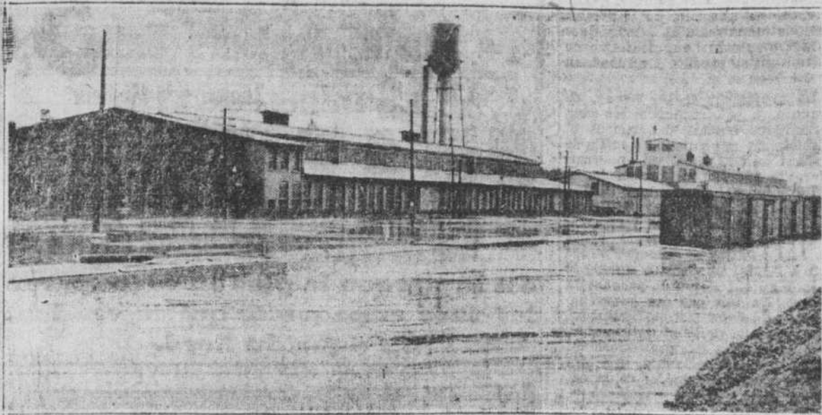
L'INONDATION A SHERBROOKE.—La manufacture Jenkes, près du marché, que les eaux de la rivière S.-François ont envahie et la voie du chemin de fer submergée. L'eau atteint le plancher des wagons. (Cliché Sears, Sherbrooke).
