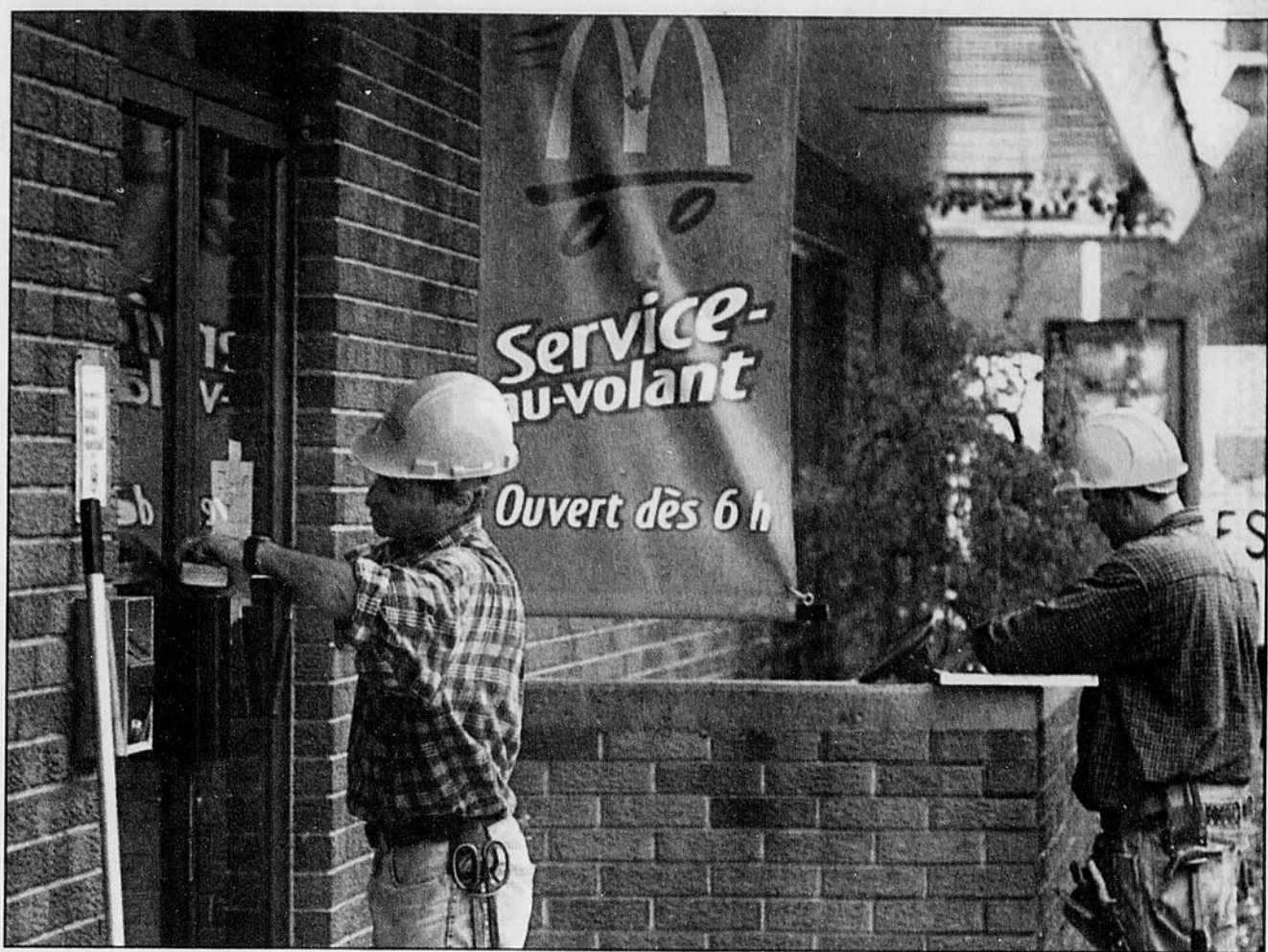
Des ouvriers spécialisés se sont vite affairés à réparer les dégâts, hier, au McDo de la rue King Est, à Sherbrooke.
