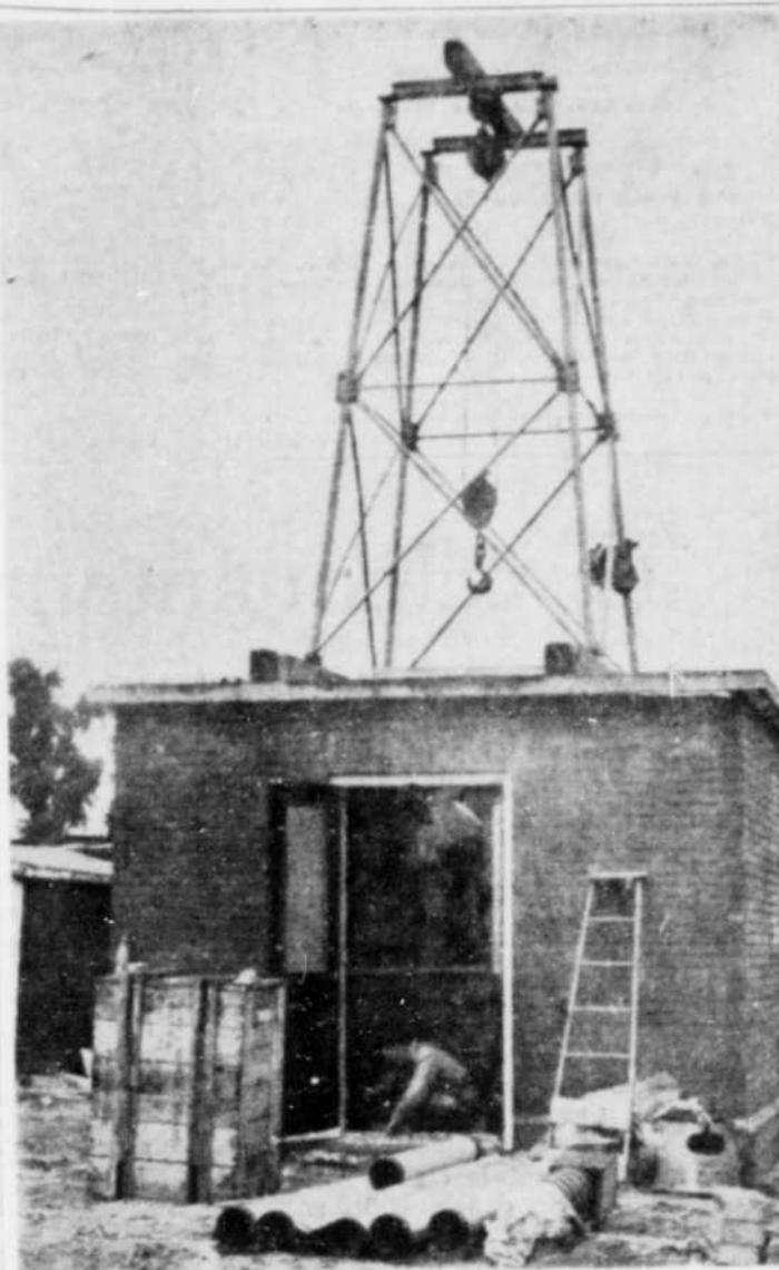
UN NOUVEAU Puits sera mis en opération, bientôt sur la rue Vallières de Saint-Réal. C'est le premier de deux nouvelles unités dont la construction a été ordonnée par le conseil pour ajouter au volume d'eau en attendant la construction de la nouvelle usine de filtration. On achève actuellement la construction de l'abri et l'aménagement de la machinerie.
